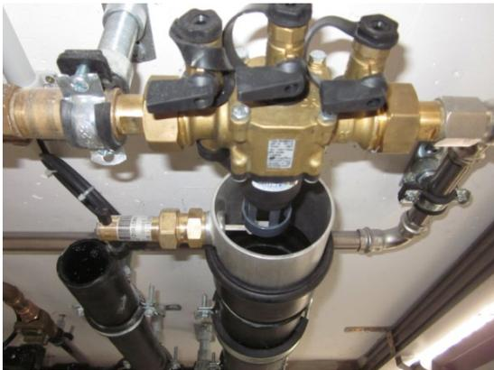
Disconnecteur Hiltbrand Typ: BA-BM (écrou raccord)
