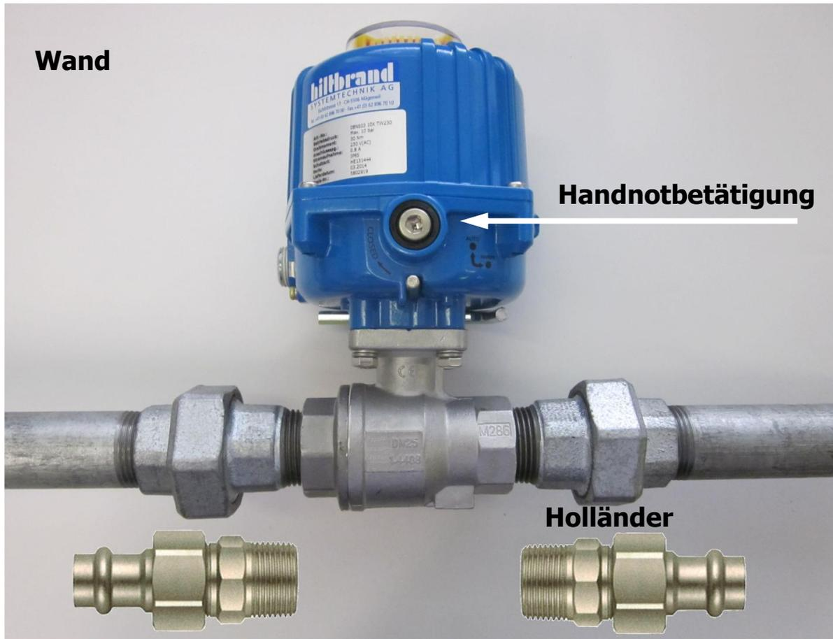
**Kugelhahn so installieren, dass die Handnotbetätigung nach vorne zeigt.**
